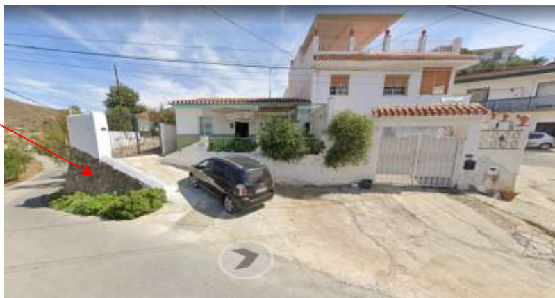
Imagen 3. Vista del ámbito con el muro de contención ejecutado
