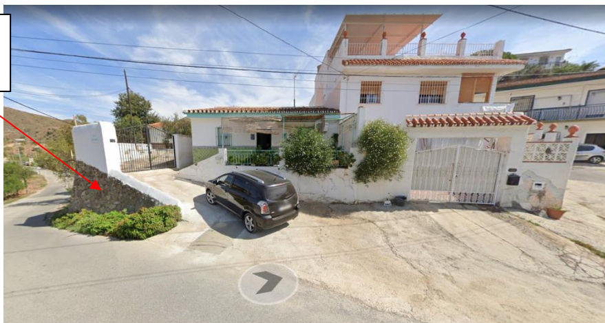
Imagen 3. Vista del ámbito con el muro de contención ejecutado
