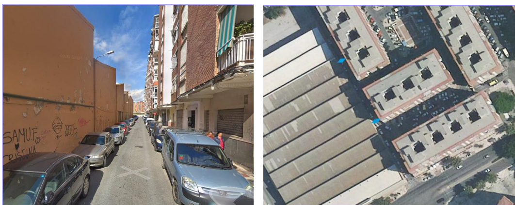
Calle Balazón estado y ancho actual.
