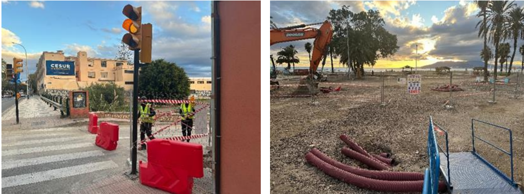
* Estado actual de la zona de aparcamiento libre.
