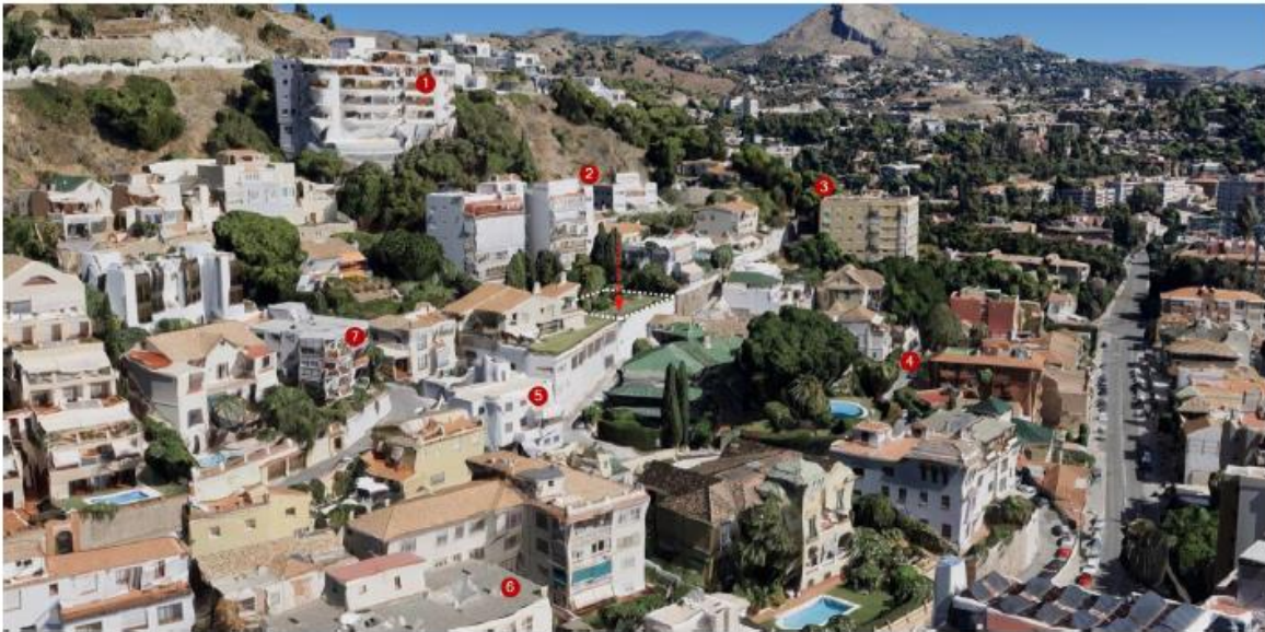
Imagen 2. Edificaciones con alturas superiores a las de la propuesta
